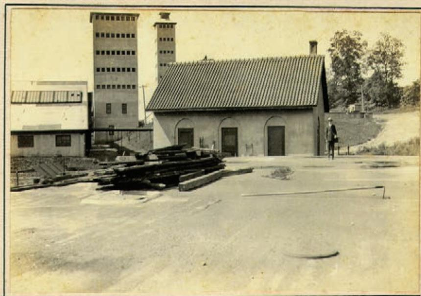
Mt. Vernon, N.Y. - Parte coberta: tanque septico, torres para absorção de gazes, à esquerda um dos leitos (sprinklin filters) coberto. À direita o laboratório.
