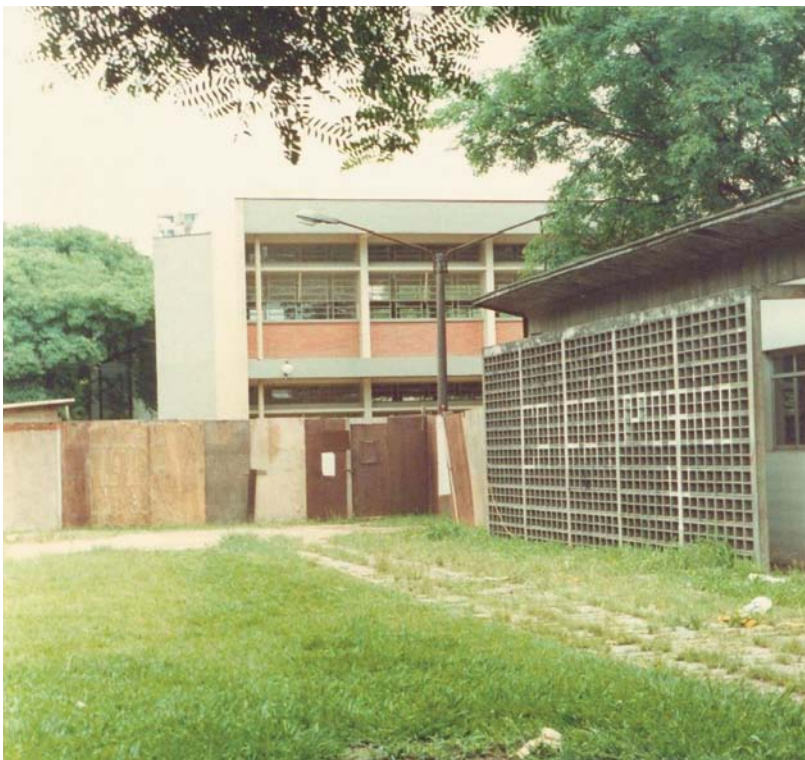
Biblioteca do IPUSP: antigas e novas instalações.
